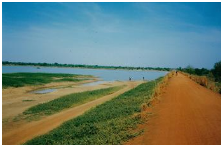
Une simple digue de terre qui n'a pas coûté une fortune, suffit déjà à retenir une importante quantité d'eau qui a redonné vie à tout un environnement humain. Photo. J-MT 2001
