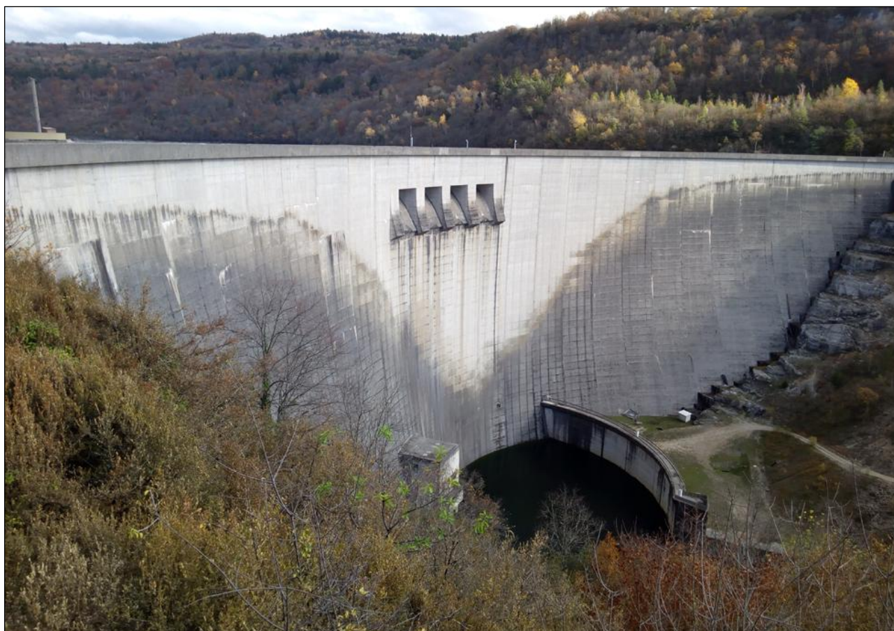
Barrage hydroélectrique de Vouglans (EDF) sur la rivière l'Ain (Département du Jura - France). Puissance 285 MW. Photo. J-MT
