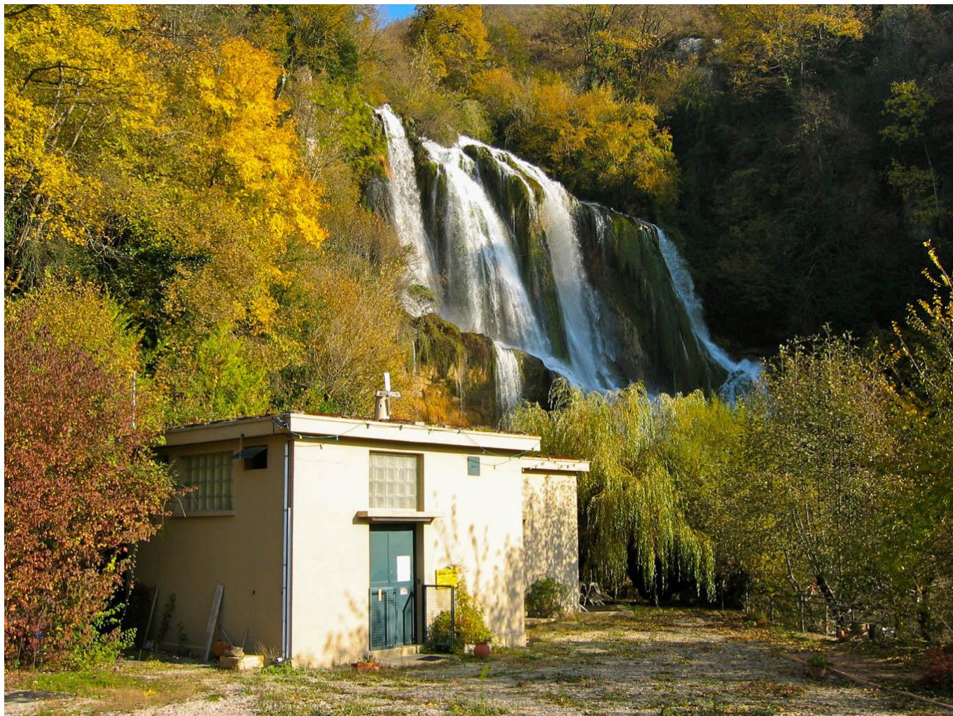
Centrale hydroélectrique privée de Glandieu (Département de l'Ain) sur le torrent le Gland. D'une puissance de 750 kW nets pour une production de 2.2 GW/h/an, elle exploite une chute de 66 m. Photos. Sté. FGM via internet.
