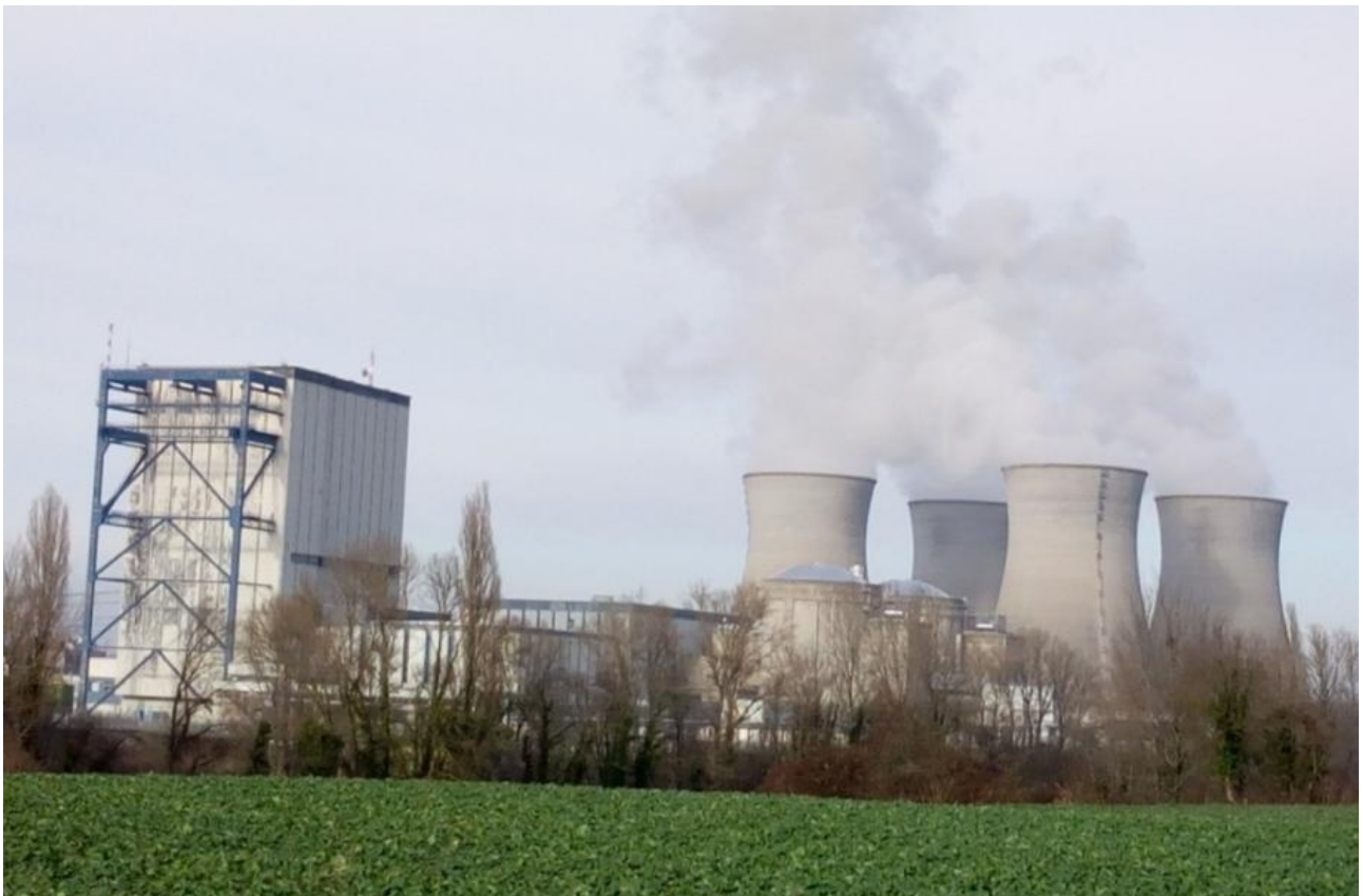
Centrale nucléaire du Bugey (département de l'Ain à \approx 40 km à l'Est de Lyon) soit une tranche UNGG de 550 MWe (définitivement arrêtée depuis 1994, en cours de démantèlement) et quatre tranches REP de 905 MWe bruts dont deux sur réfrigérants atmosphériques. Ces quatre tranches seront les premières arrêtées dès 2029/2030, soit 3 480 MW nets. Photo. JMT 2017
